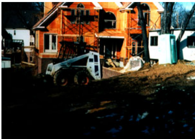
Figura 10 – La alta tasa de erosión de los sitios en construcción es la mayor fuente de escorrentía en las áreas desarrolladas. Los materiales erosionados contribuyen a la acumulación de arcilla y la eutroficación en los lagos, ríos y océanos costeros.
